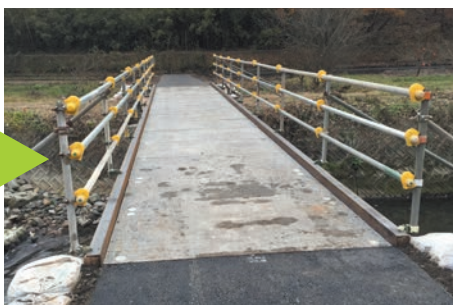
仮設橋を設置(歩行者、二輪車専用)
