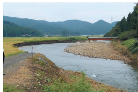
市道が破損した田川(石那田町)
