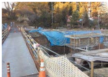
市道670号線の田川に掛かる(通目鬼橋)
